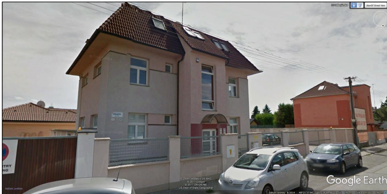
Obr. 9 Pohľad na administratívnu budovu (severná strana)
