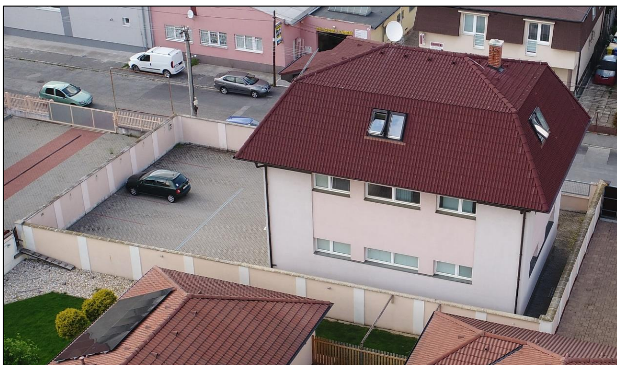
Obr. 6 Pohľad na administratívnu budovu z južného smeru
