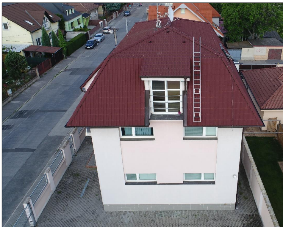
Obr. 8 Pohľad na administratívnu budovu zo západného smeru
