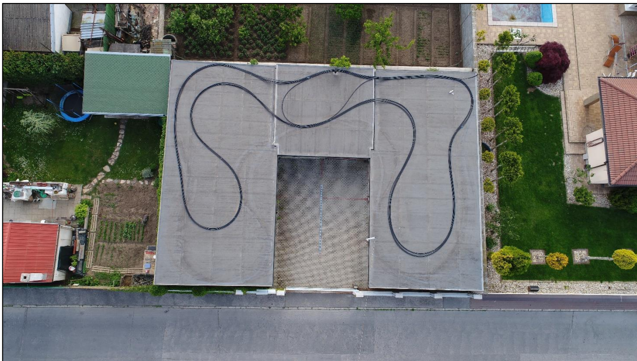
Obr. 7 Pohľad na garáže zhora
